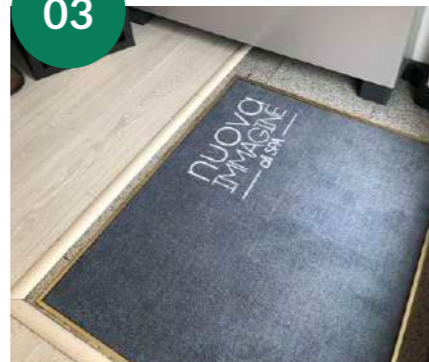
INSTALLAZIONE DELLO ZERBINO DOORMAT INSTALLATION
